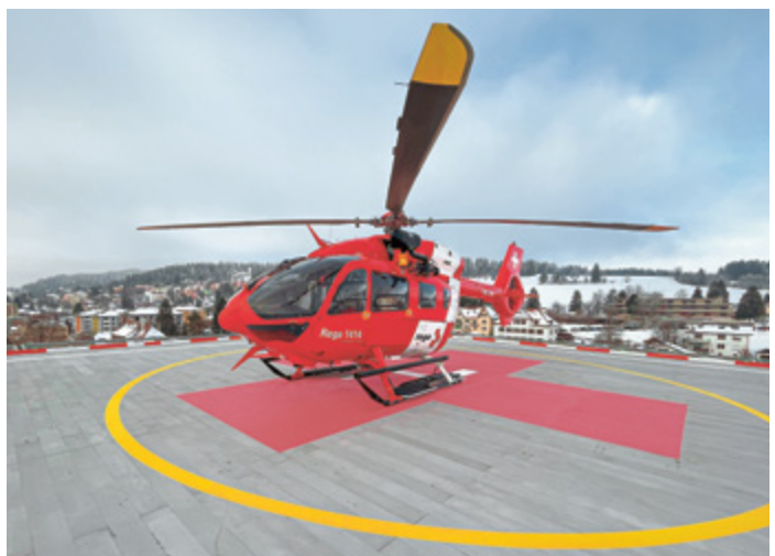
Der neue Landeplatz auf dem Dach des Spitals La Chaux-de-Fonds.
