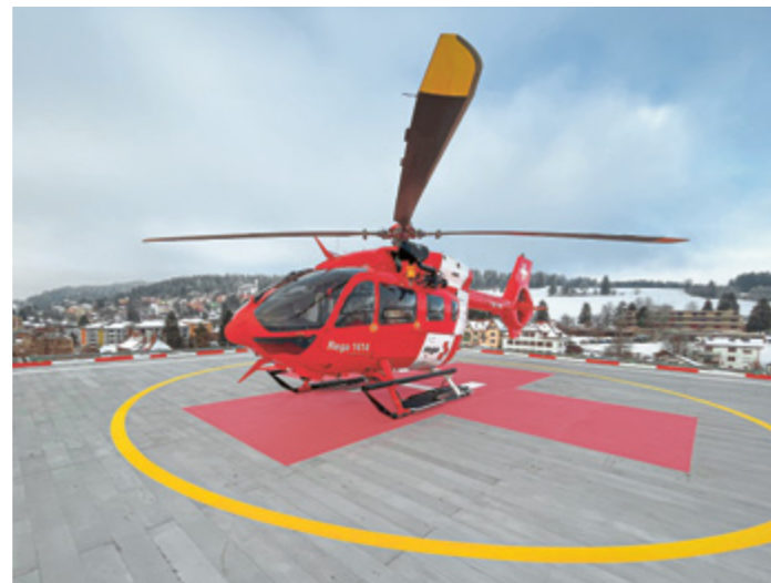
Il nuovo eliporto sul tetto dell'ospedale di La Chaux-de-Fonds.
