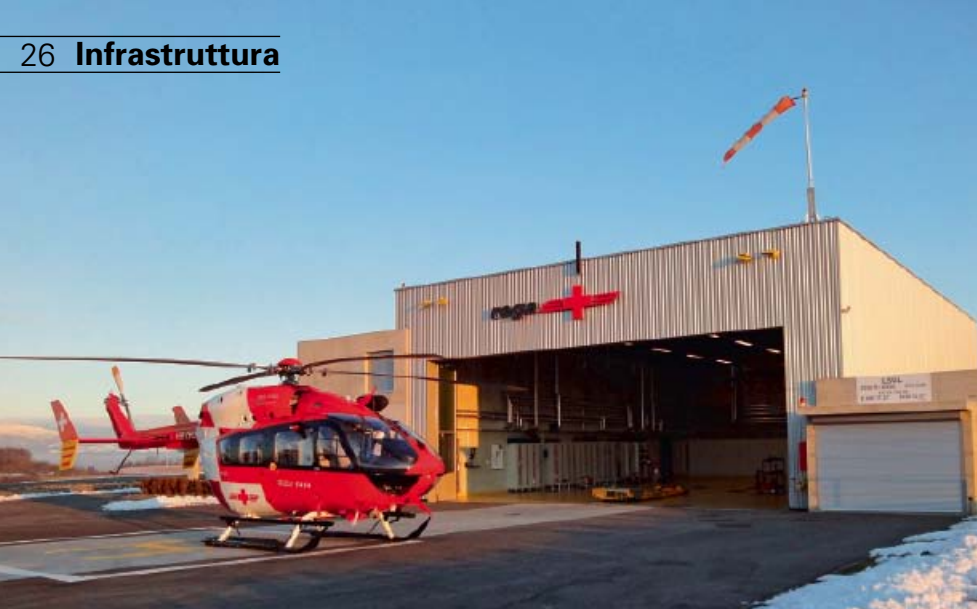
Tutto sotto un sol tetto: la nuova base Rega Losanna inaugurata nel 2010.
